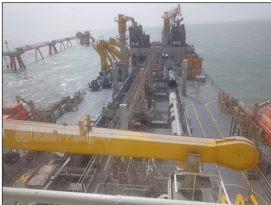
Figura 11. Panoramica del ponte della draga durante le attività di scavo.
