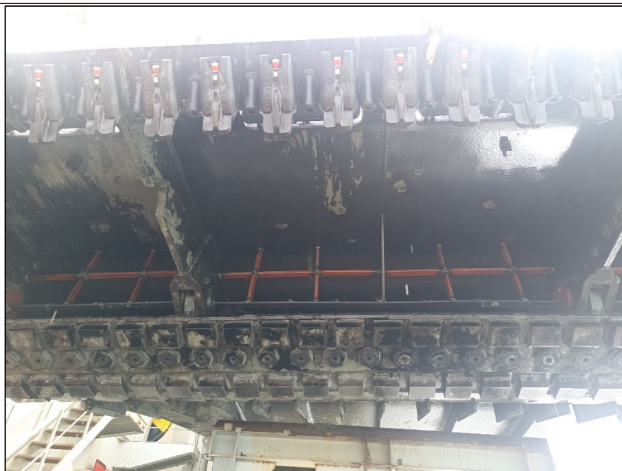
Figura 10. Particolare della testa durante le fasi di controllo
