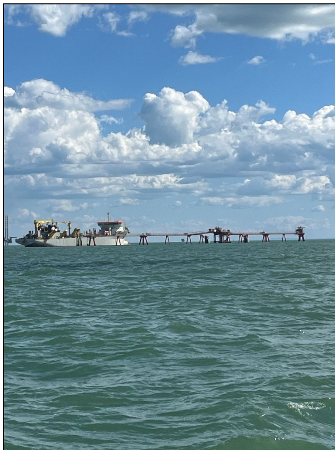
Figura 15. Panoramica della draga all'opera.
